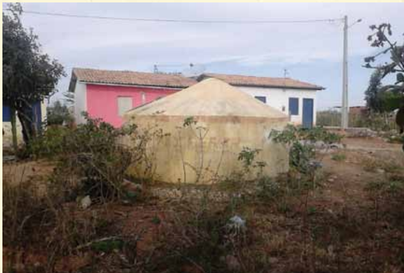
Cisternas construídas em cada casa da comunidade.
