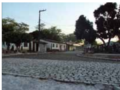
As moradias em Ladeiras e o calçamento das ruas.
