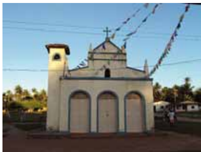
Fachada da Igreja de Santo Antônio.
