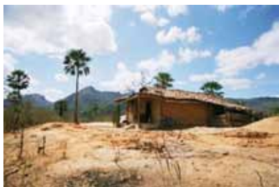
Timbaúba de Cima
